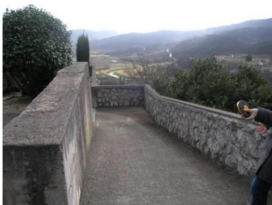
Slika 4. Rampa između dva dograđena grobna polja
