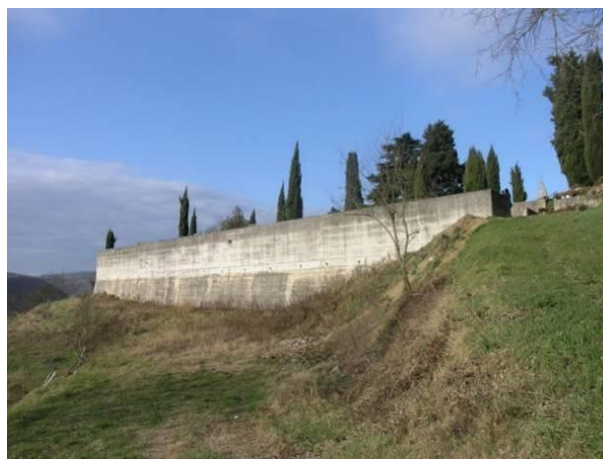
Slika 7. Pogled na potporni zid postojećeg groblja
