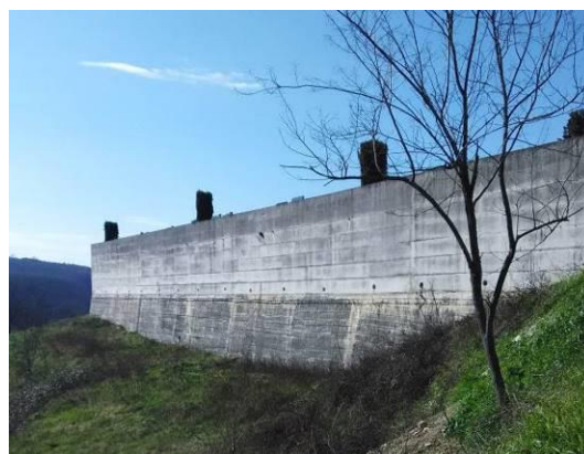
Slika 5. Potporni zid (posljednja faza proširenja)
